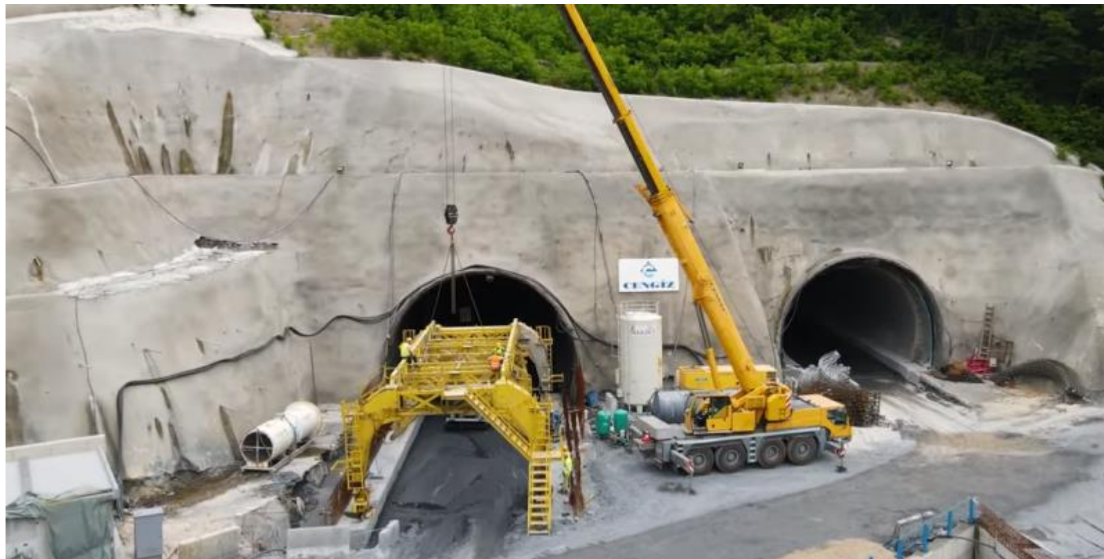
Izlazni, južni portal tunela Golubinja
